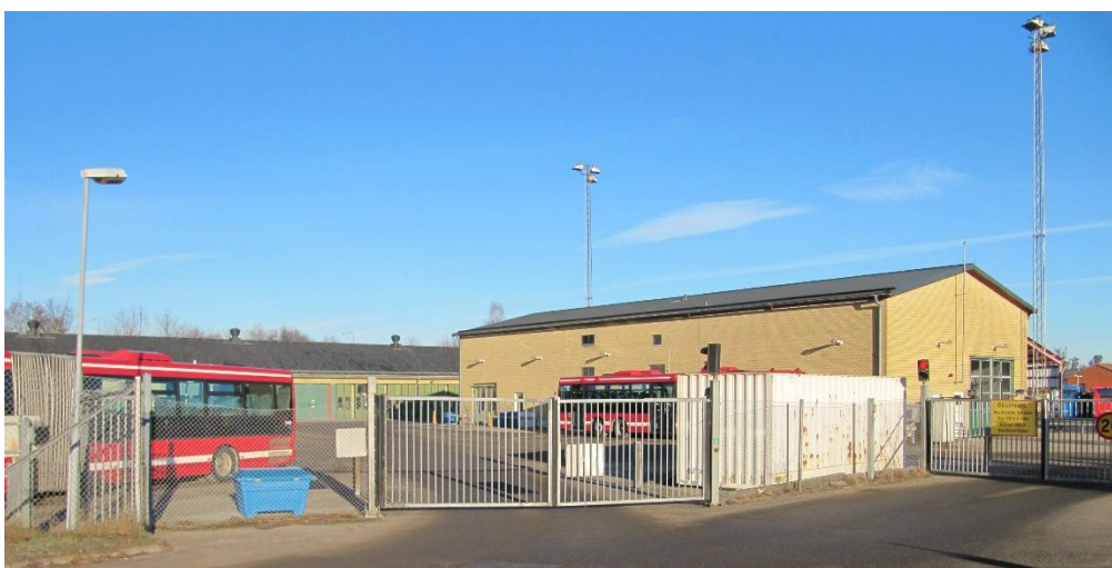
12 och 13 Delar av bussdepån. Vy mot väster. Garagebyggnaderna är uppförda i gult tegel med flacka sadeltak och grönmålade dörrar. Foto: SWECO Architects
