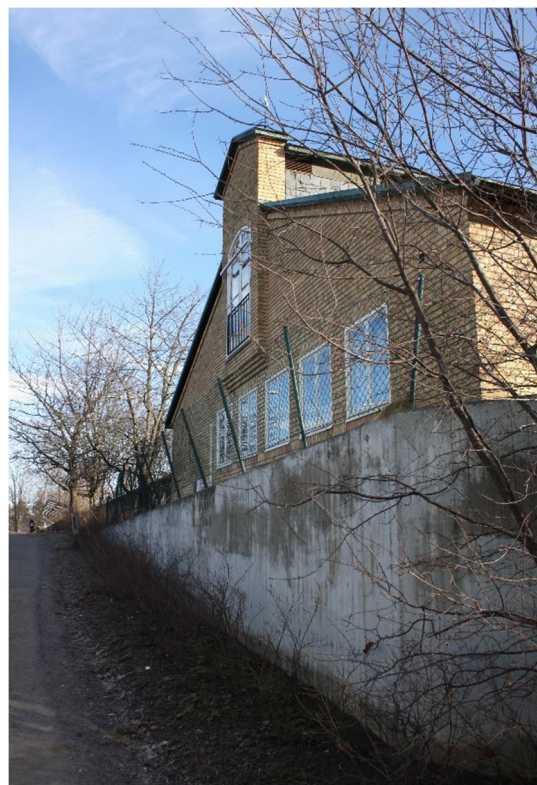
14 och 15 Bussdepåns "huvudbyggnad" har en karaktäristisk gavel mot väster och är tydligt exponerad mot Ekerövägen. Byggnaden har en enkel dekor i den gula tegelfasaden och täcks av flackt sadeltak lagt med skiffer. Foto: SWECO Architects
