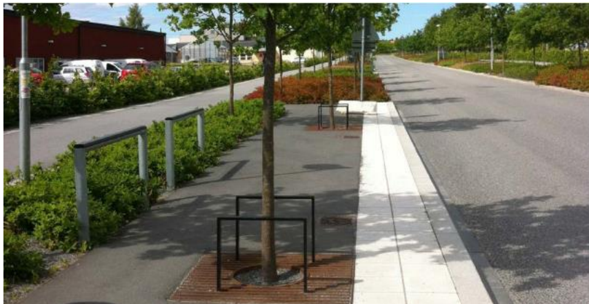
Figur 9. Exempel på träd med skelettjord i en alléplantering på Ulls väg, Uppsala. Marklagret är till stor del hårdgjort vilket gör att anläggningen är mycket utrymmeseffektiv. Bild från Banach m.fl., 2015.
