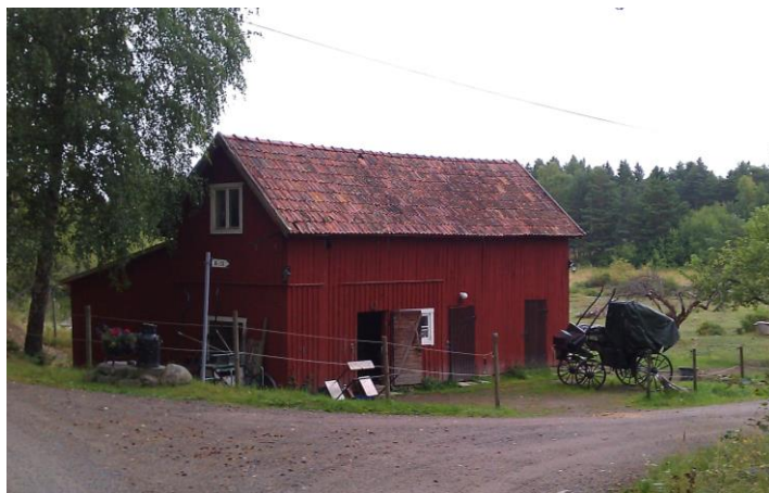
Befintlig stallbyggnad på Kungsberga 1:6.
