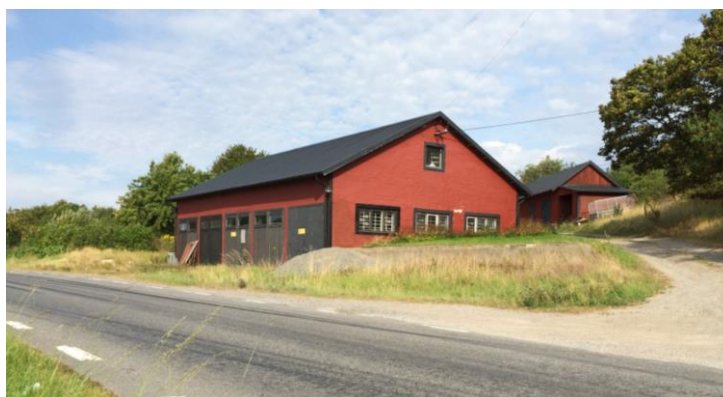
Befintlig garagebyggnad vid Kungsbergavägen.
