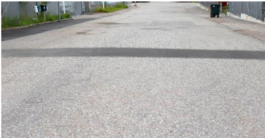
Exempel på återställning av asfalt
