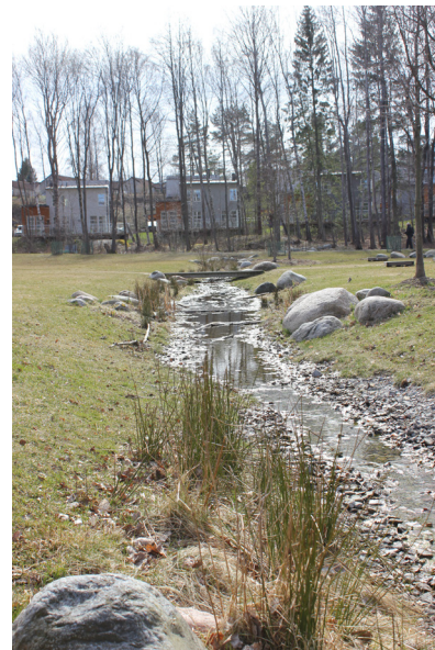
Dagvattenhantering i svackdike (Skarpnäck).
