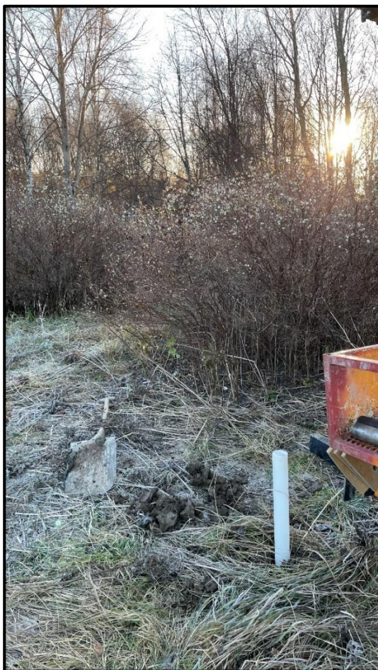
Figur 5. Installerat grundvattenrör i provpunkt 21NC02.
