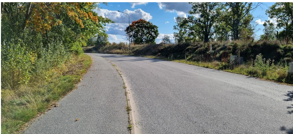
Figur 6. Bild på Uppgårdsvägen från gångbanan på östra sidan.
